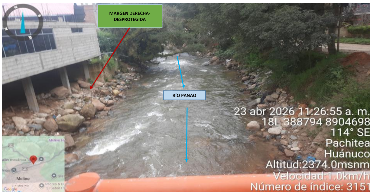
IMAGEN 03: EN ESTE TRAMO SE OBSERVA EN LA MARGEN DERECHA DEL RÍO PANO, QUE LAS VIVIENDAS CERCANAS AL RÍO SE ENCUENTRAN SIN PROTECCIÓN
